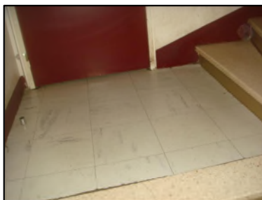
Photo N° 6085 REVETEMENT DE SOL --escalier +1 à +3 Planchers Dalles de sol 30x30 avec colle noire
