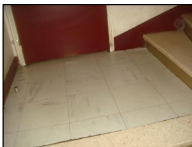
Photo N° 6085 REVETEMENT DE SOL --paliers +1 à +3 Planchers Dalles de sol 30x30 avec colle noire
