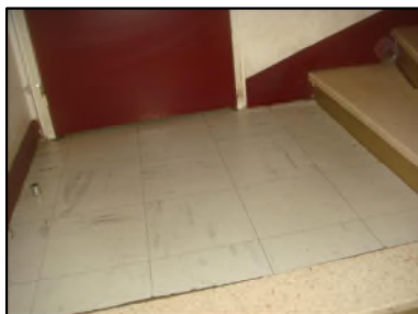
Photo N° 6085 REVETEMENT DE SOL --PALIERS +1 à + 3 Planchers Dalles de sol 30x30 avec colle noire
