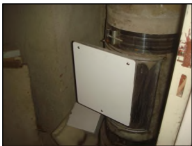
Photo N° 6054 AMIANTE CIMENT - -LOCAL VO -1 à +4 Conduits de fluide Gaine V.O.(Fibres-ciment)
