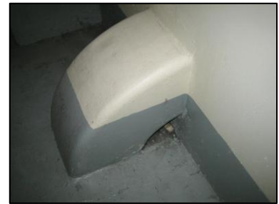
Photo N° 13 ECH-N°4 AMIANTE CIMENT --Couloir (sous-sol) Gains & coffres horizontaux Ventilation basse (Fibres-ciment)
