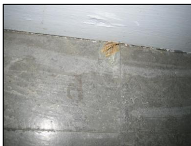
Photo N° 24 ECH-N°10 REVETEMENT DE SOL --Réserves 1+ 2 Planchers Dalles de sol noire 30x30 avec colle jaune
