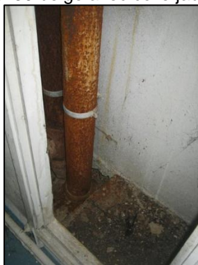
Photo N° 8 ECH-N°1 --Gaine technique (sous-sol) Planchers Béton gris
