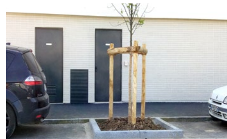
Point de collecte situé rue au 552 rue Paul Émile Victor
