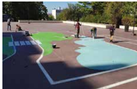
▲ Le chantier devrait s'achever à la fin du mois d'octobre 2020.
