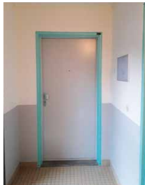
▲ Démarrés en septembre dernier, les travaux se sont achevés en décembre.
