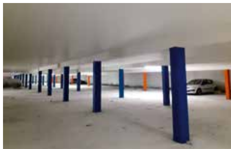
▲ La rénovation du parking souterrain a été engagée et offrira aux locataires un espace plus clair et totalement réhabilité.
