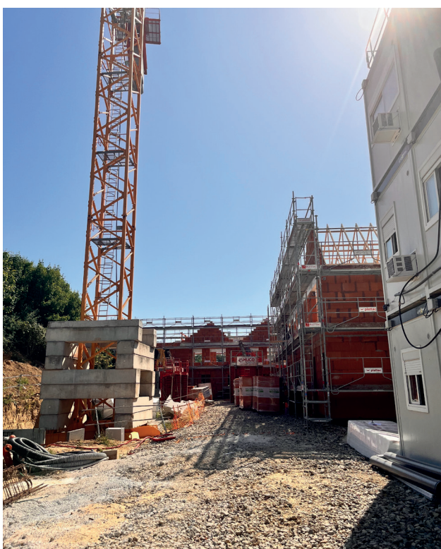
Résidence avenue de Tyreso à Savigny-le-Temple
