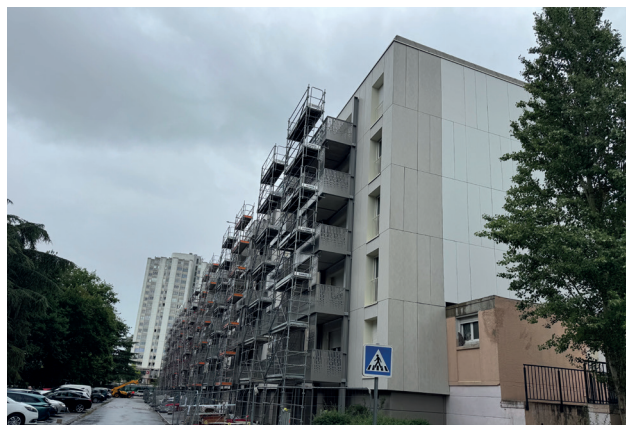
Réhabilitation au Square de l'Abbaye, Dammarie-lès-Lys
