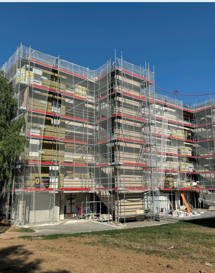
Réhabilitation de la résidence Four à Chaux, Brie-Comte-Robert
