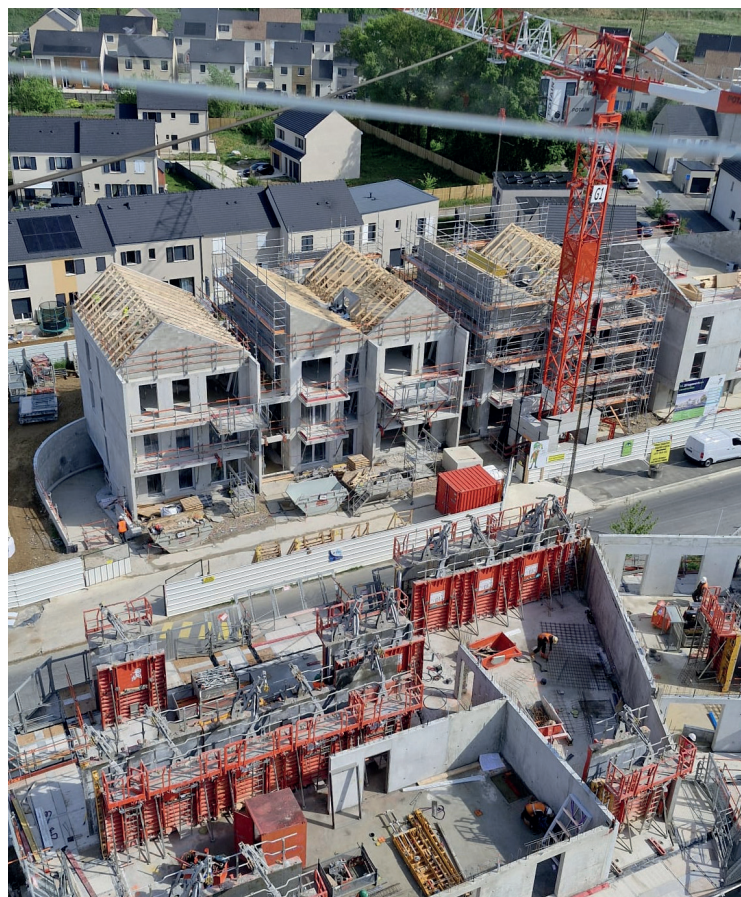
Construction de la résidence Woodi à Melun
