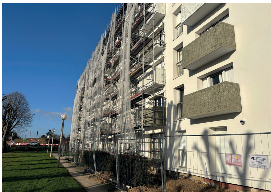
Réhabilitation de la résidence Beauregard à Melun
