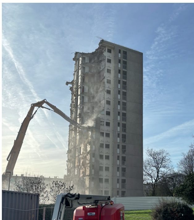
Démolition de la Tour Lorient, Melun, novembre 2025
